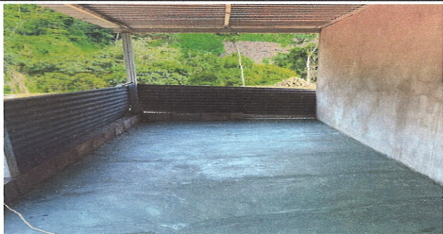
Foto1: Mejoramiento e instalacion de piso torta de cemento
