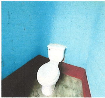
Foto 5: Mejoramiento de sanitario
