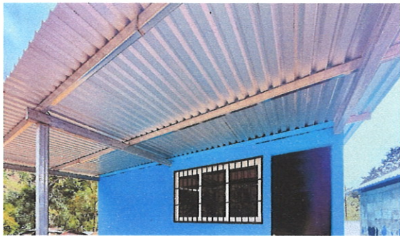
Foto 2: Mejoramiento de estructura metalica y techo troquelado
