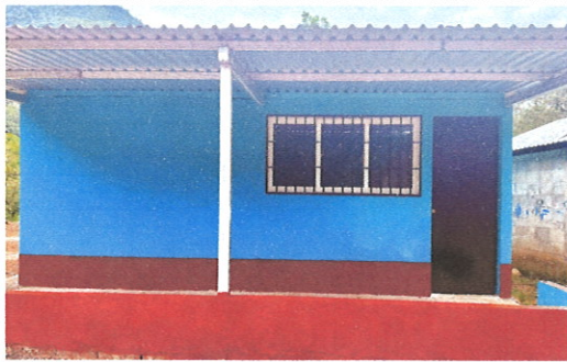
Foto 6: Mejoramiento de corredor modulo aula
