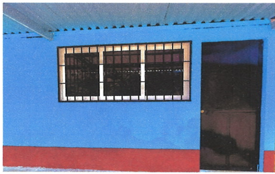
Foto 4: Mejoramiento de puerta y ventana
